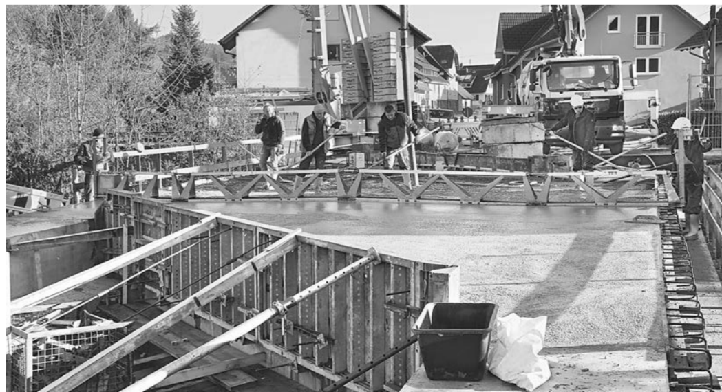
Die Kaffeebrücke hat weiter Form angenommen. Hier wurde die Fahrbahn betoniert.
