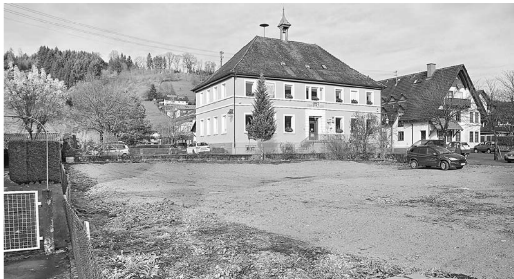
Auf der linken Seite entlang des bereits geschotterten Platzes wird eine neue Zufahrt zum Kindergarten und zur Arztpraxis angelegt. Fotos: Ute Berger/Hanspeter Schwendemann
